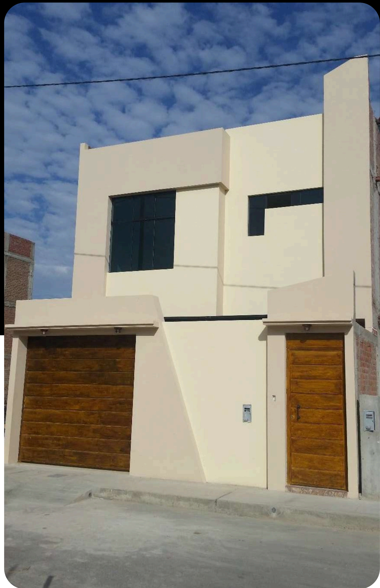
CONSTRUCCION DE VIVIENDA UNIFAMILIAR EN MIRAFLORES COUNTRY CLUB
