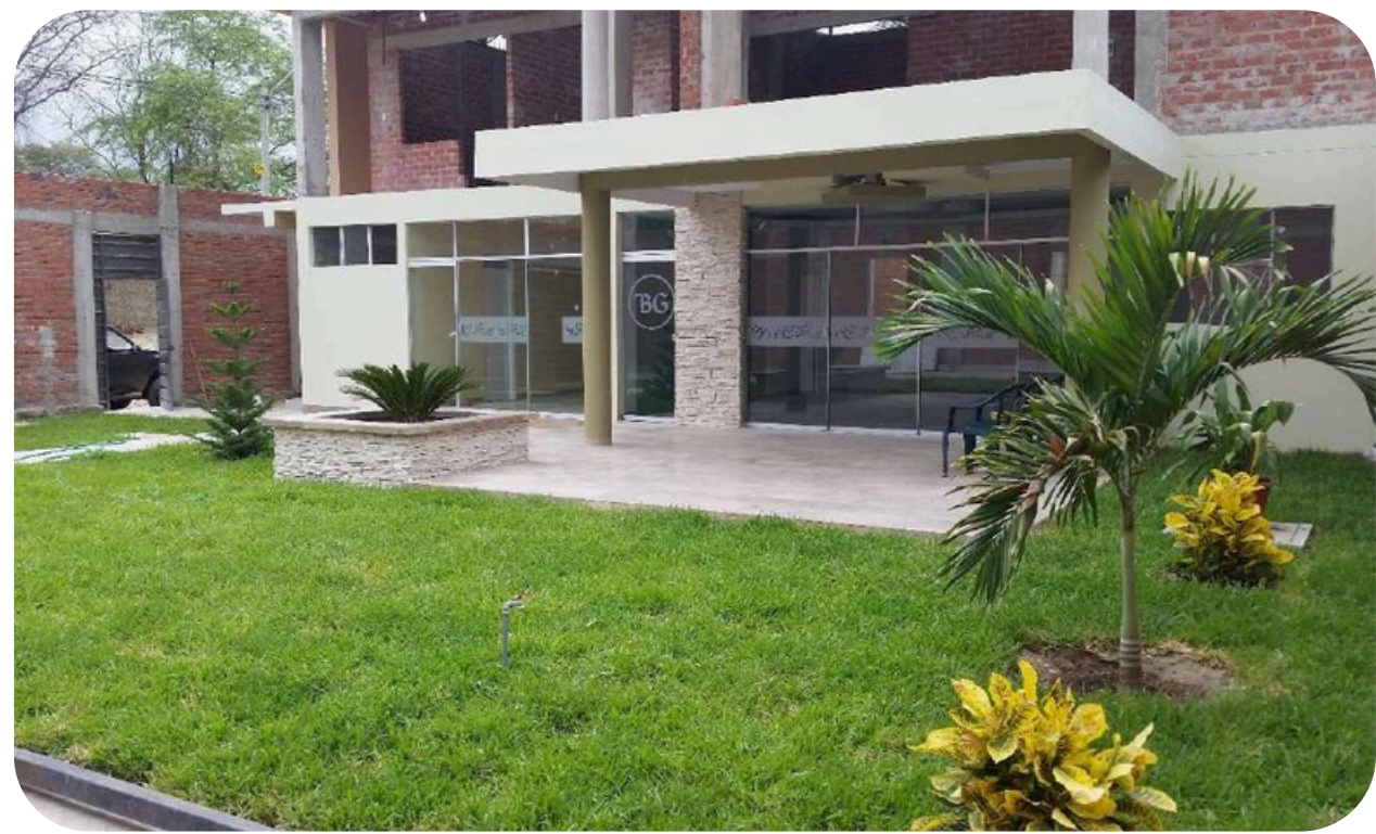
CONSTRUCCION DE VIVIENDA UNIFAMILIAR EN LOS EJEIDOS
