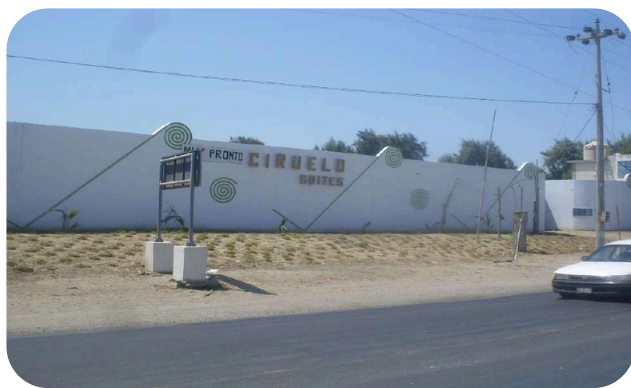
CONSTRUCCION DE MOTEL EL CIRUELO SUITES EN CRUCE LA LEGUA
