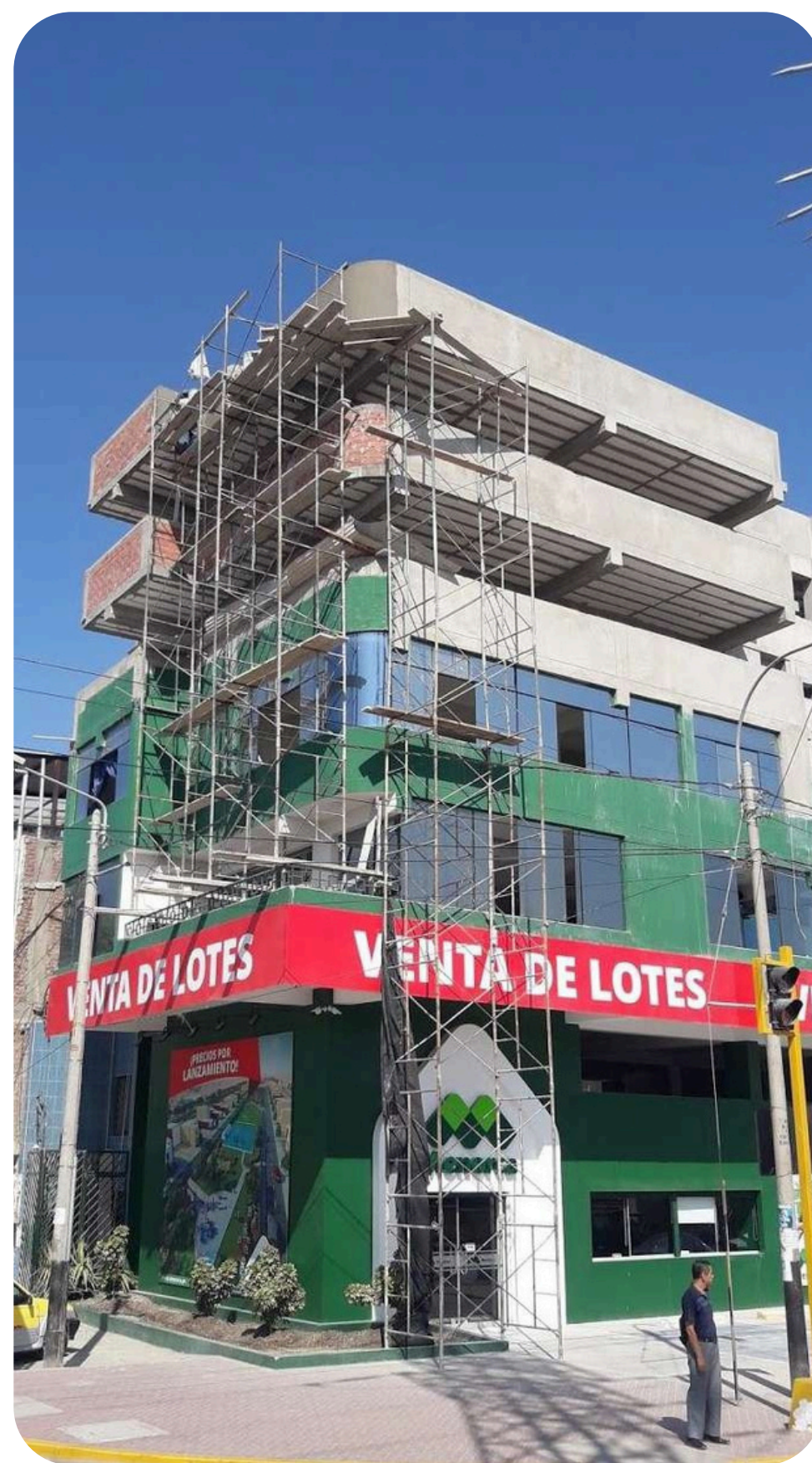
CONSTRUCCION DE 5TO Y 6TO PIURA EDIFICIO STIVEN
