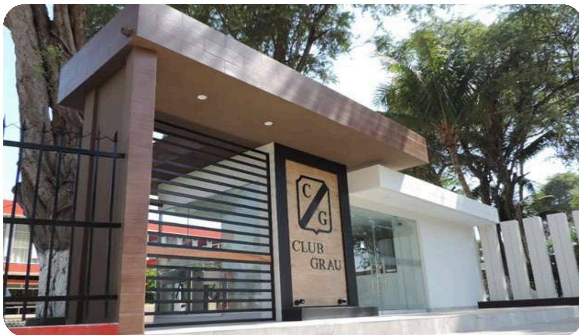
REMODELACIÓN DEL INGRESO PRINCIPAL Y SECUNDARIA DEL CLUB GRAU DE PIURA
