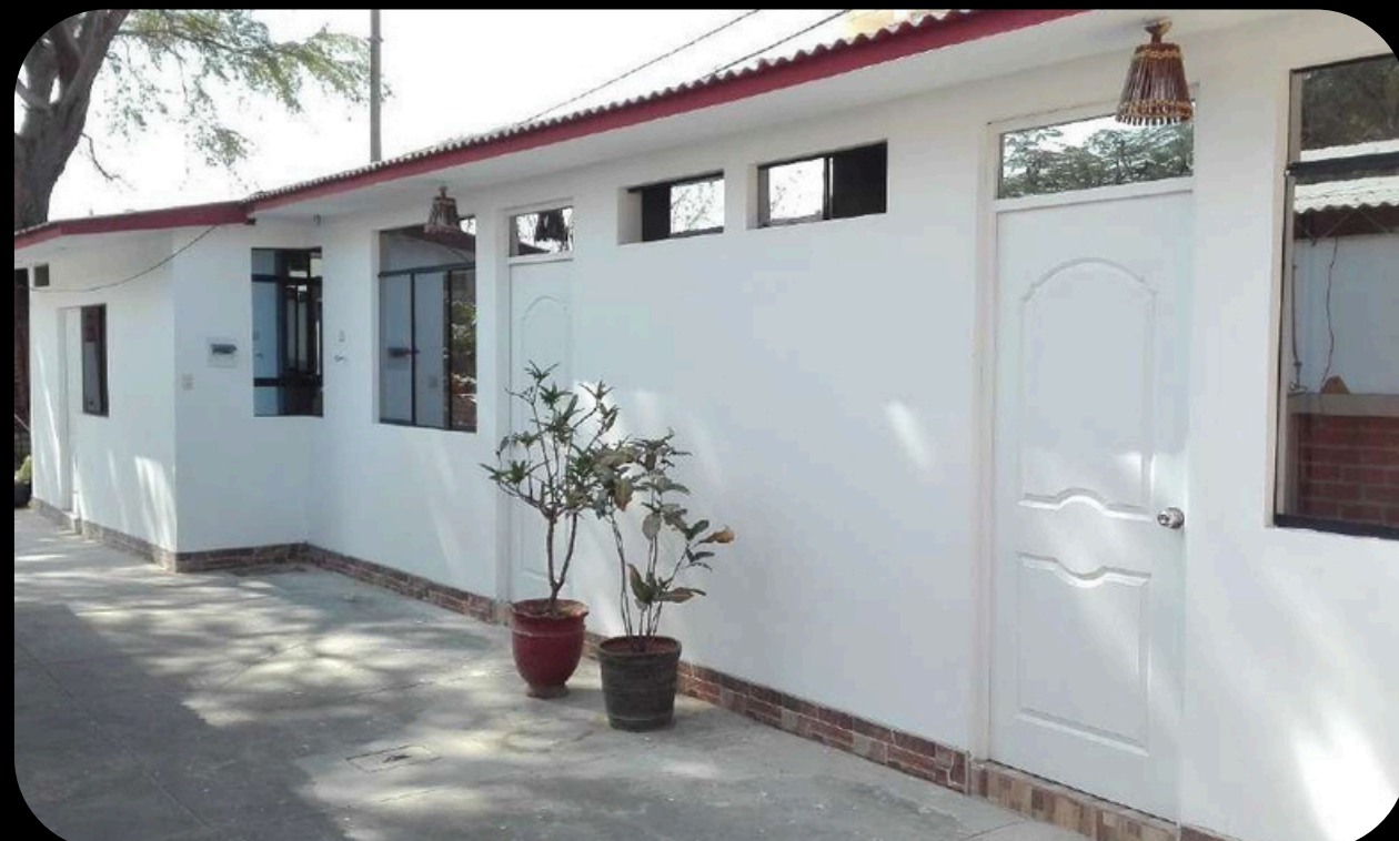
CONSTRUCCION DE RESIDENCIA VILLA SOFIA
