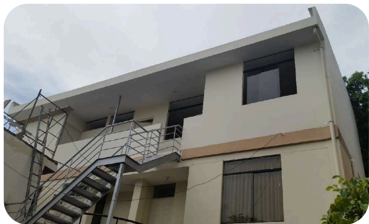
CONSTRUCCION DEL 3ER PISO SISTEMA DRYWALL LA LAGUNA DEL CHIPE
