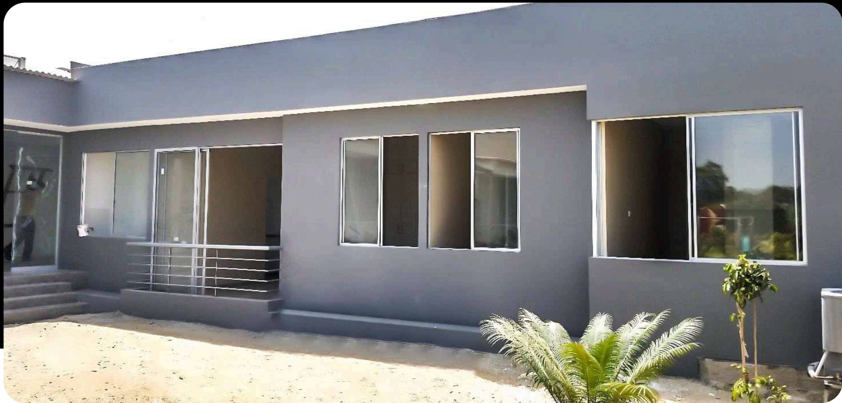
CONSTRUCCION DE CASETA DE VENTAS Y CASA MODELO DE EDIFICA
