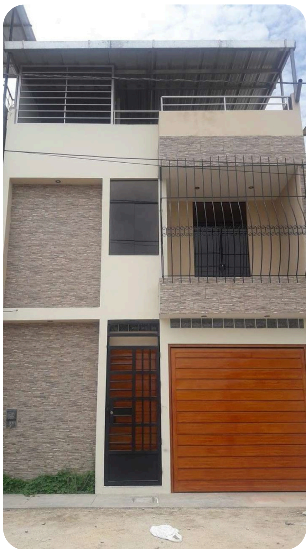
CONSTRUCCION DE CASA EN URB. EL TREBOL - PIURA
